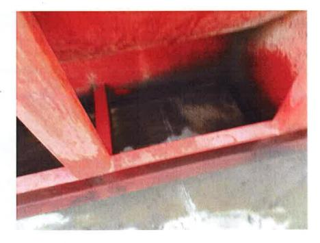
TYPICAL BRACING FOR TANK BOTTOM & SKID
