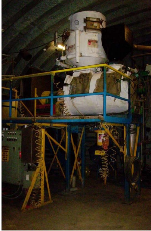
Photo 21. PF-II Thermal Desorber (12/2014)
