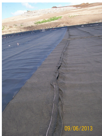
Geomembrane-composite Interface
