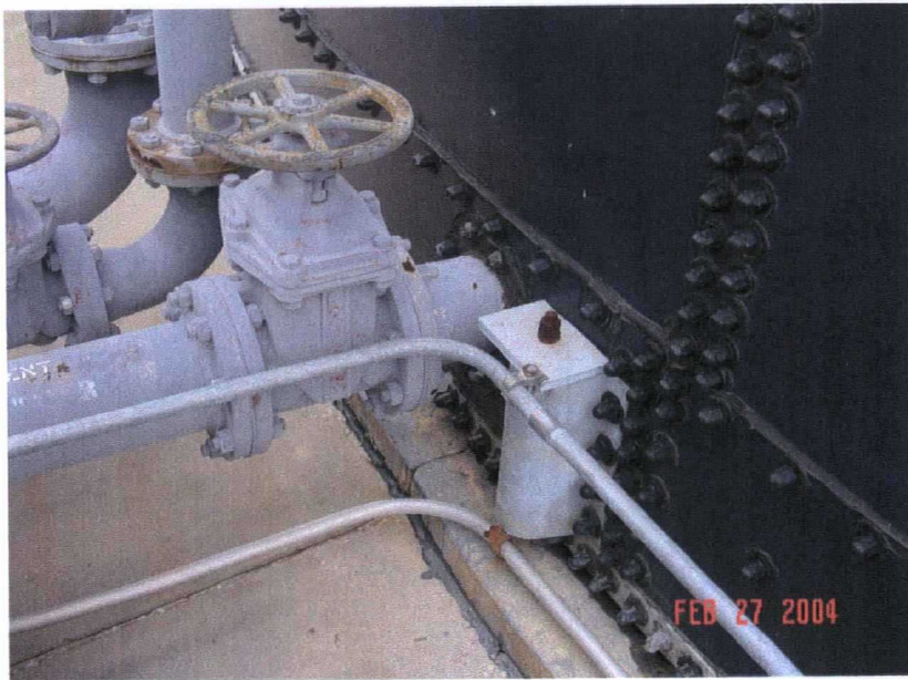
11. Lower nozzle exterior.
