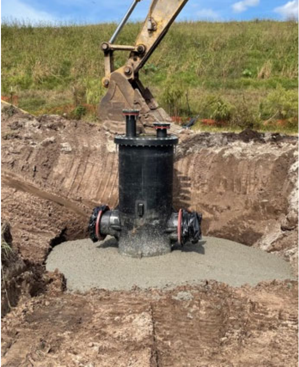
Sump Installation CS-12
