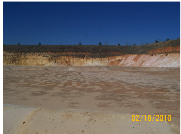
Future Fill Area 5
