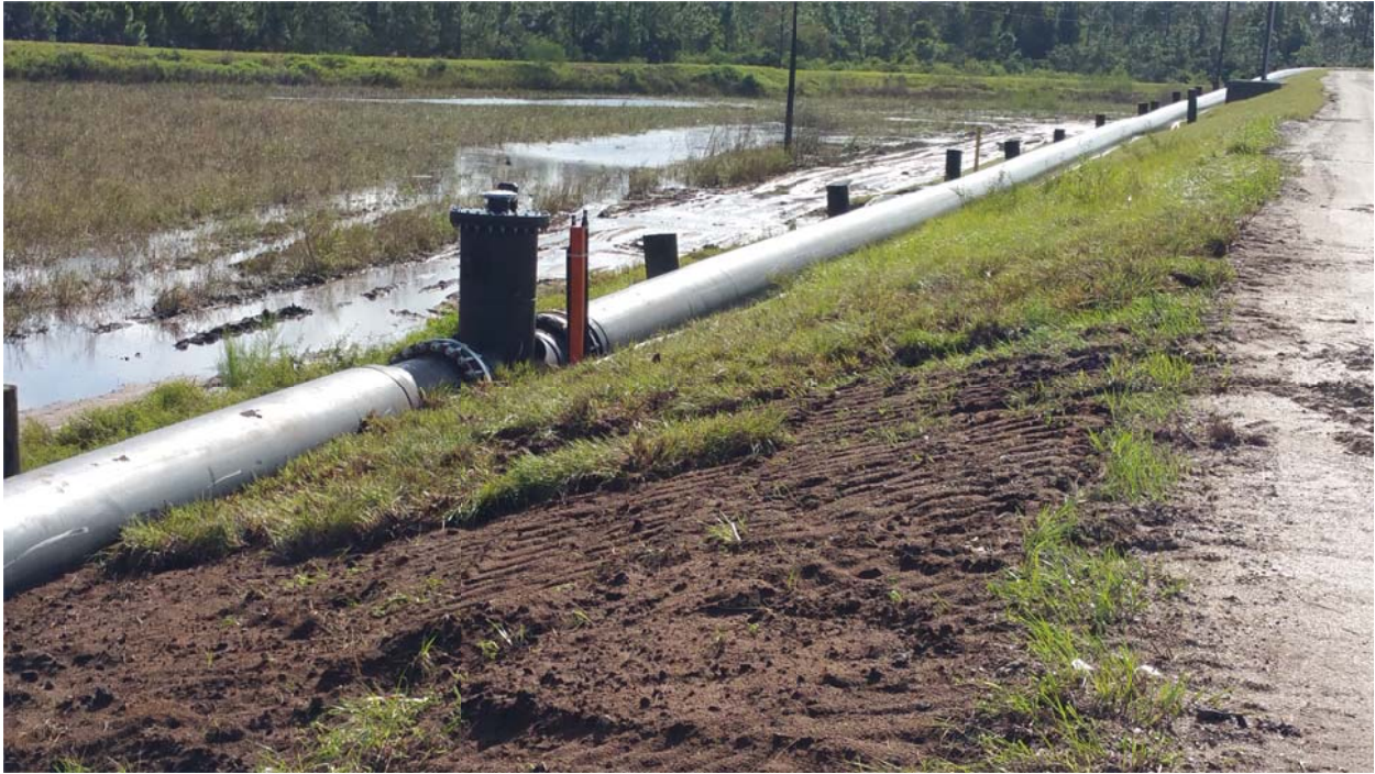
28" HDPE Condensate Sump
